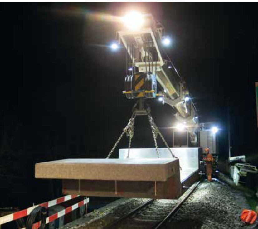
Einbringen und Vorspannen Schottertrug Assembling and pretensioning of pre cast ballast hutch
