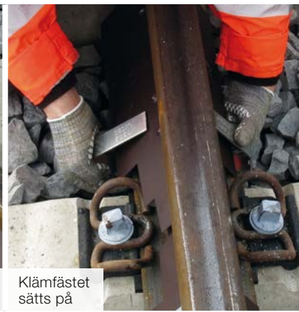
Dämpare trycks sätts fast på spåret
