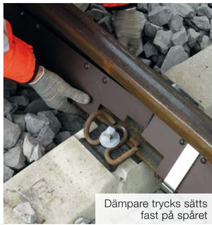
Klämfästet sätts på
