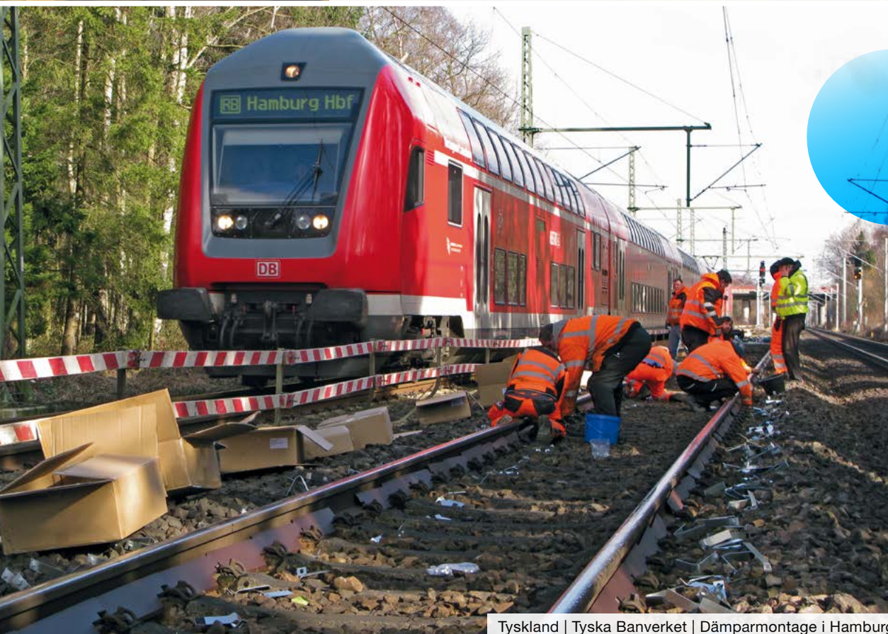
Montage av dämpare Calmmoon Rail under natten, efter att trafiken stängts av
